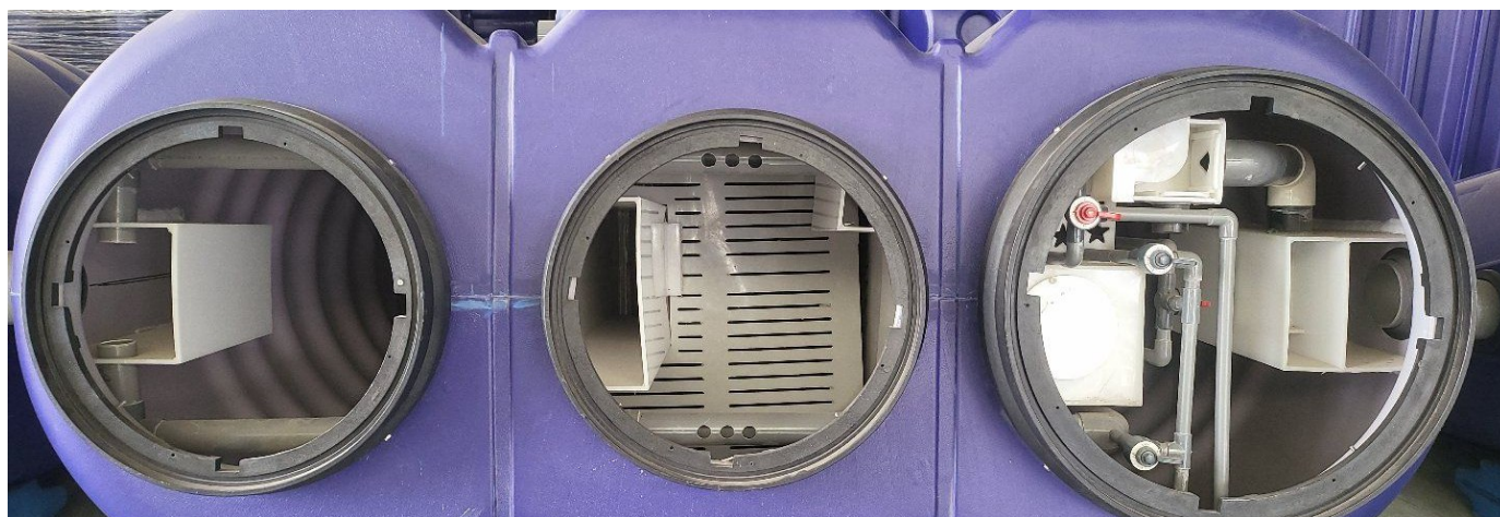
El tanque con sus tres tapas de acceso abiertas: deflectores internos, medios de biopelícula y tubería de aire. Cada etapa es alcanzable desde la superficie.
